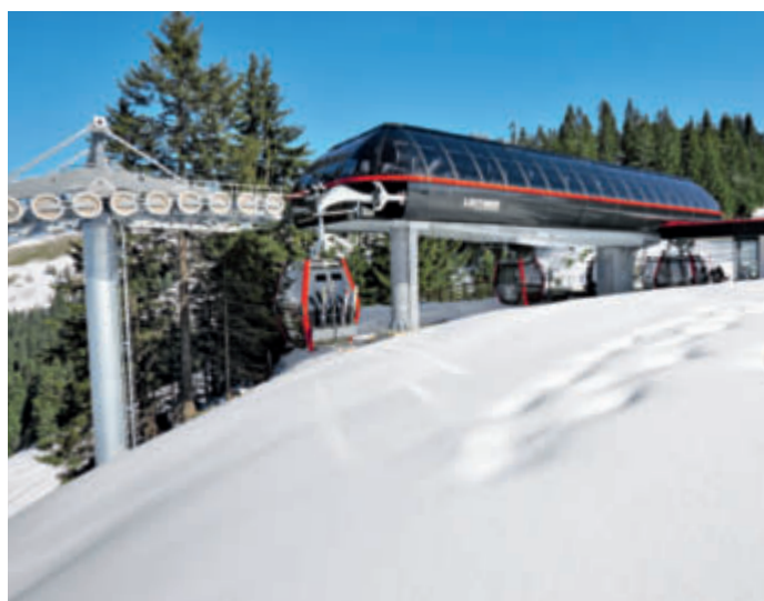
Верхняя станция подъемника „Maierlbahn“ (Фото: Leitner)
