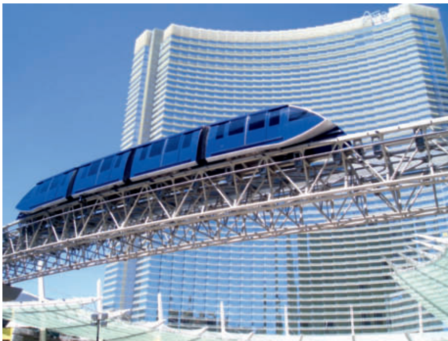
"Cable Liner Shuttle" компании DCC перед комплексом MGM "CityCenter"
