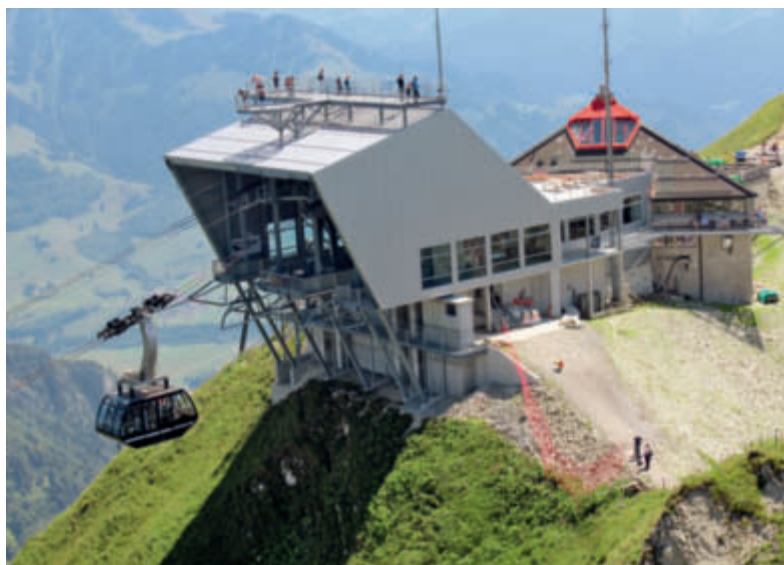
Die Bergstation wurde direkt vor dem bestehenden Restaurant platziert. Das Dach der Bergstation wurde mit einer Aussichtsplattform versehen.
