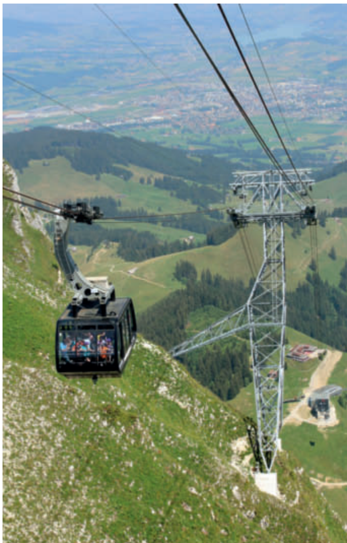
Blick von der Bergstation auf die 38 m hohe Stütze mit Querstrebe.
