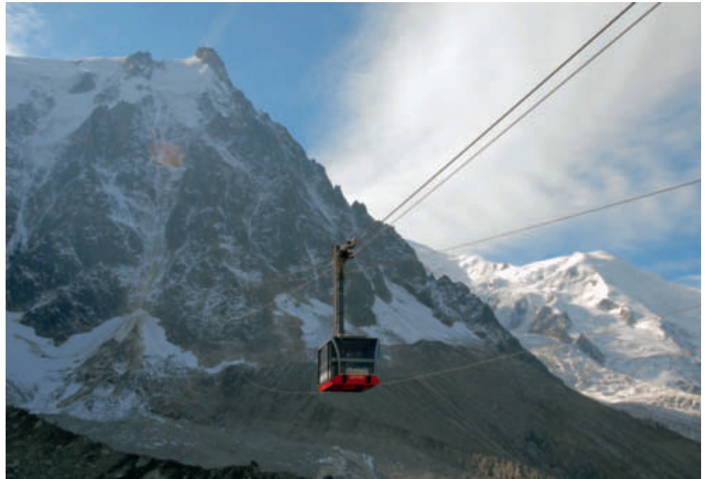
Blick von der Mittelstation auf die Trasse der 2. Teilstrecke der Pendelbahn „Aiguille du Midi“
