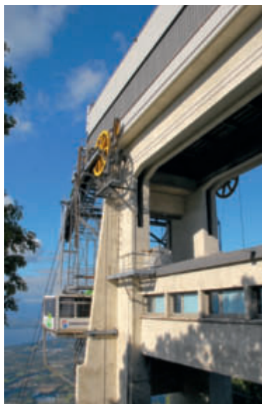
Beim Bau der Bergstation der Pendelbahn „Salève“ im Jahr 1932 wurde erstmals in Frankreich Stahlbeton für Seilbahnstationen eingesetzt.
