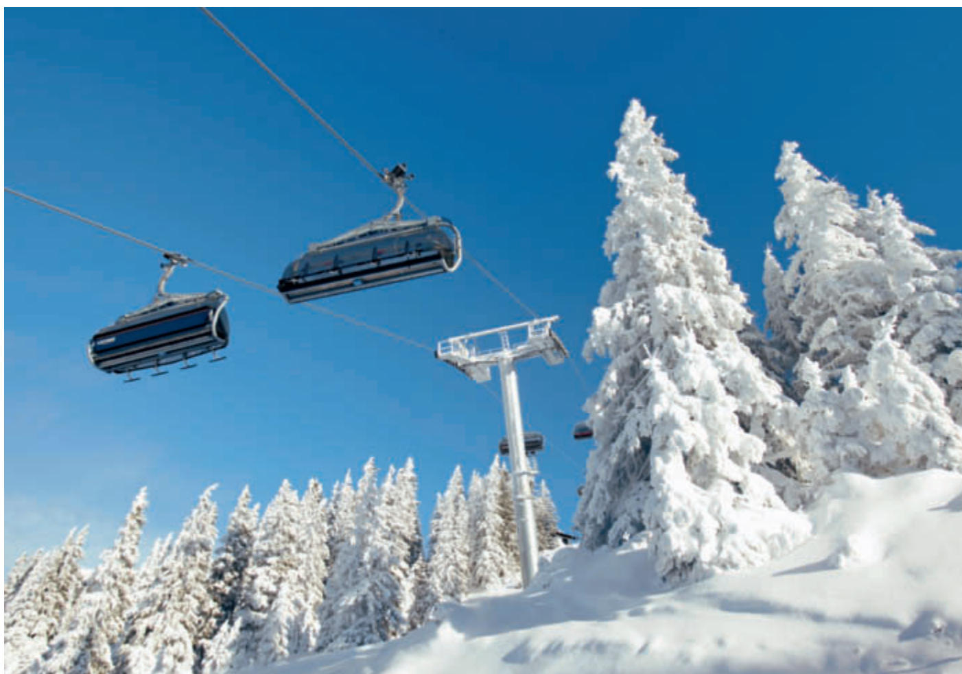
Prächtige Winterstimmung auf der Strecke der kuppelbaren 8er-Sesselbahn "Ochsalm". Die Sessel sind mit Wetterschutzhauben und Sitzheizung ausgestattet.
