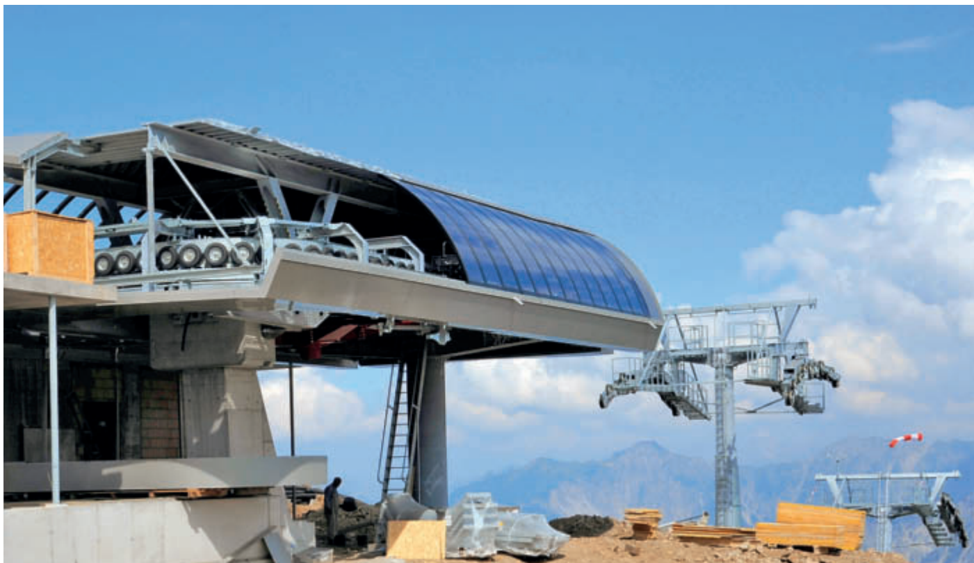
Bergstation der Hüttenkopfbahn im Bauzustand, Verglasung mit integrierten Photovoltaikelementen teilweise eingebaut
