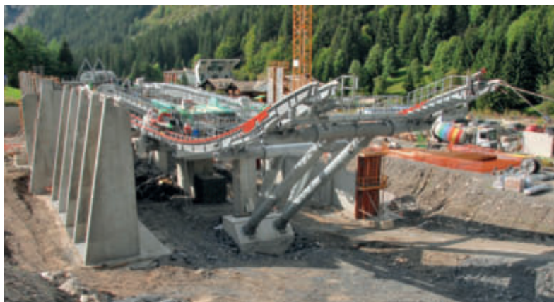
Talstation der 3S-Bahn „Prodains Express“ im Bau
